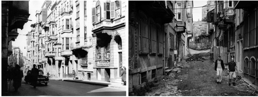
FIGURE 5.44 Tarlabası streets in the past (“Burasi Tarlabası mı?,”) and in 2014 under demolition (“Streets of Tarlabası İstanbul,” 2012)
