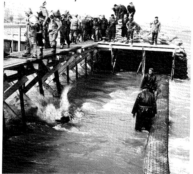
Fig. 3.10 Rollen staaldraadgaas ter voorkoming van wegspoelen zandzakken, sluiting op de Rijksweg polderwaarde 1953
