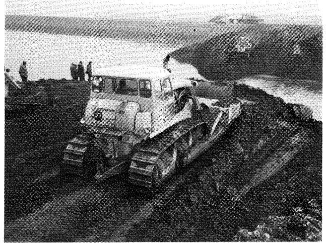
Fig. 6.18 Laatste fase zandsluiting
