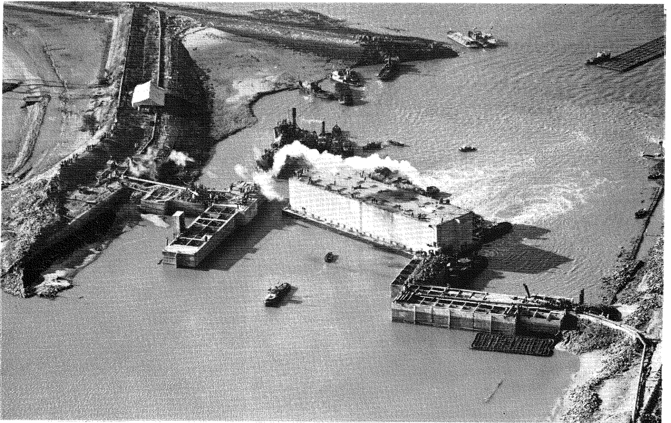
Fig. 3.7 Blokking van Veerhaven Kruijningen met laatste caisson, 1953
