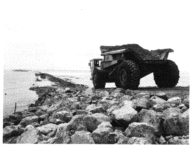
Fig. 6.10 Uitrijden van de kade met dumpers
