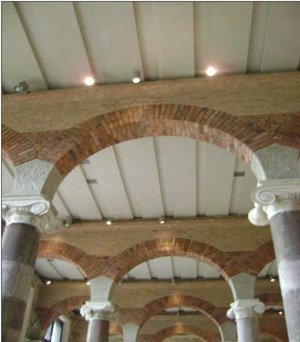
Figuur 5.5: Details plafond Neues Museum. De kolommen zijn deels oud. De gemetselde bogen en de daarop liggende betonnen vloeren zijn nieuwe toevoegingen. Elke ruimte in het museum is op een andere wijze gerestaureerd, maar overal is herkenbaar wat oud en wat nieuw is.
