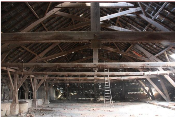
Figuur 5.6: De houten kapconstructie van steenoven De Plasserwaard in Wageningen.
