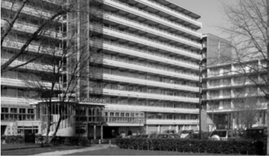
'Gooioord', one of the renovated flats of the Bijlmermeer.
