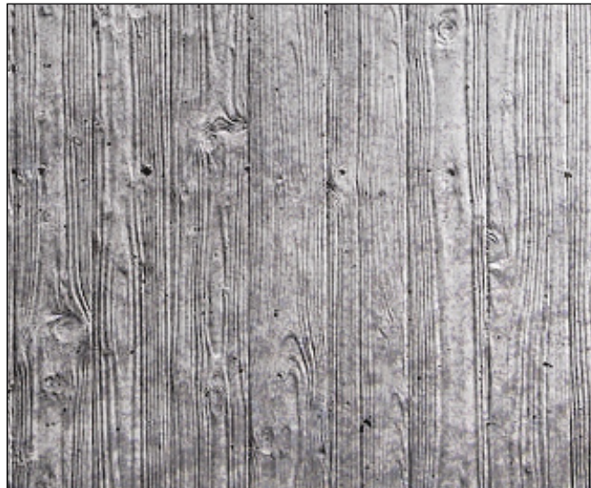
bewerking buitenkant: reliëf door houten bekisting
