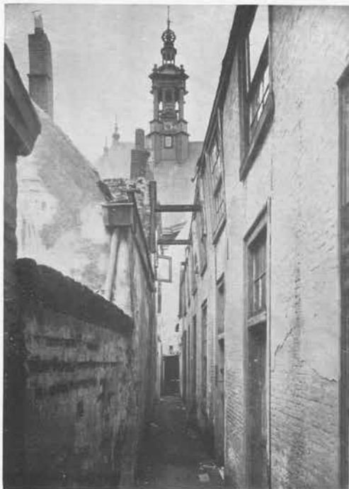
Slop aan de St. Jacobstraat
