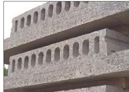
Figuur 63: aanzicht oude wingvloer [Betonson] 41
