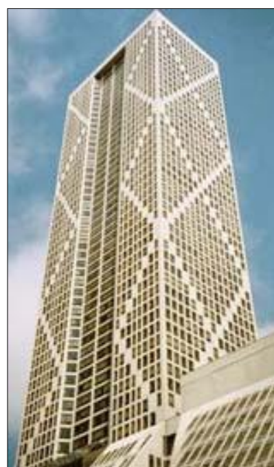
Figuur 19: voorbeeld betonnen geschoorde buis, Onyiah building in Chicago [Daniel Kieköwer]
