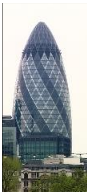
Figuur 20: Voorbeeld volledige rasterbuis, Swiss Re building in Londen [A. Zerche]
