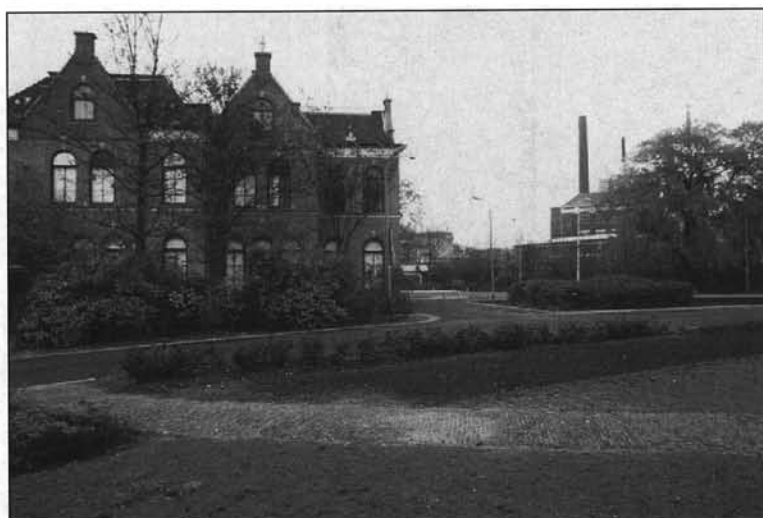
Afbeelding 3.2 Links woningbouw en voorzieningen in het Agnetapark, rechts de fabriek
