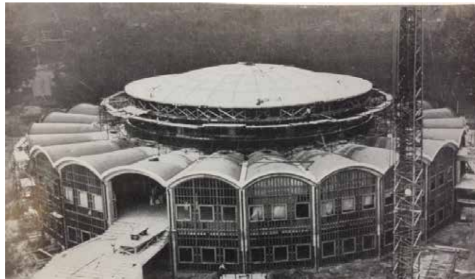
Fig. 5.5.2 ANWB building, Wassenaar, The Netherlands Räumliche Dachtragwerke: Konstruktion u. Ausführung, p. 141
