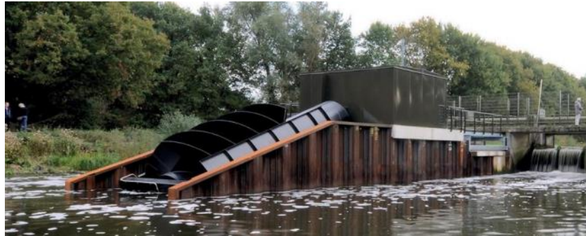
Figuur 6.1: impressie van een vijzelturbine. Een vijzelturbine geplaatst in de dommel bij St. Michiels. Afkomstig van van Heereveld et al. (2020).
