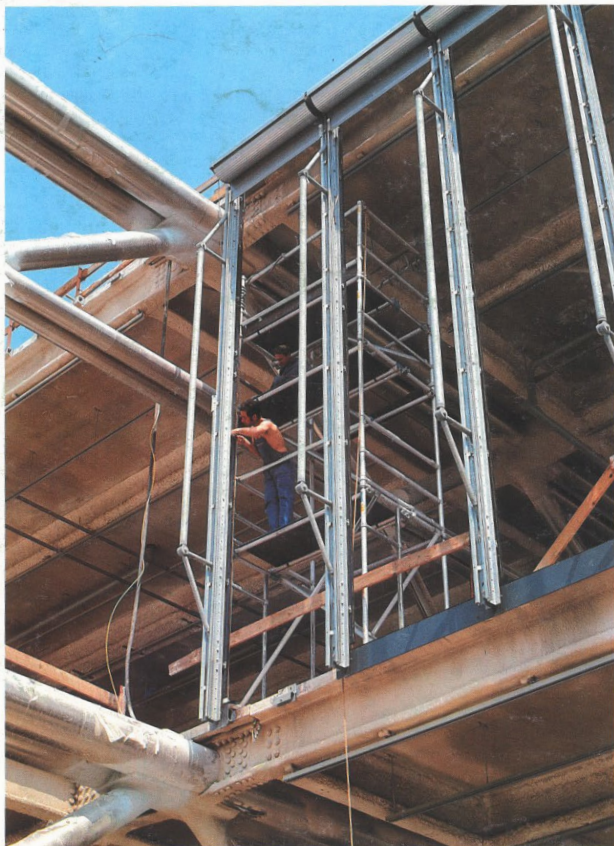
Menuiseries avec leurs raidisseurs des baies vitrées au niveau 5.
