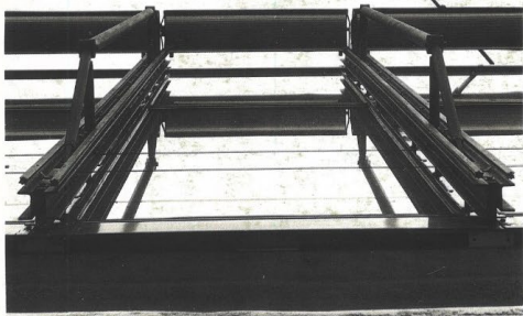
Stores électriques antisolaire externes, façade sud.
