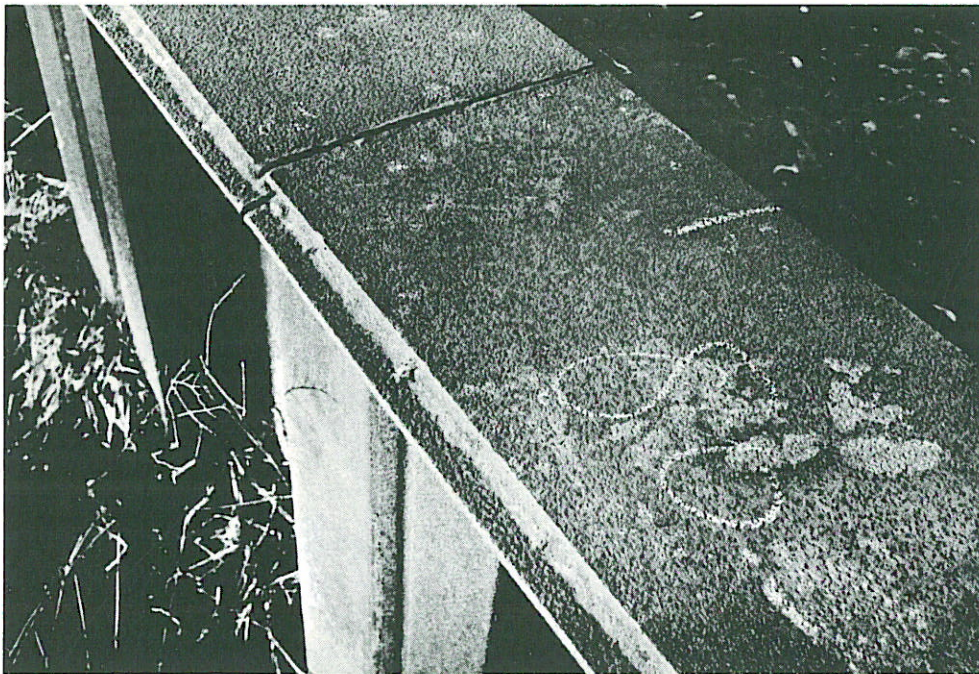
De kruin bestaat uit twee lagen plaatstaal, gelast op een damwand. De gemiddelde kruinhoogte over de eerste 80 m bedraagt N.A.P. + 13,982 m.
