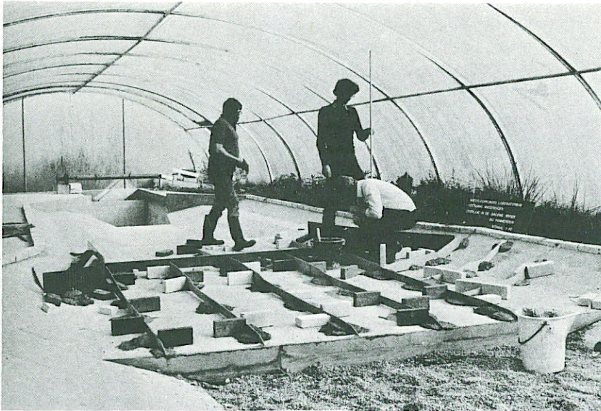
het stellen van de profielen
