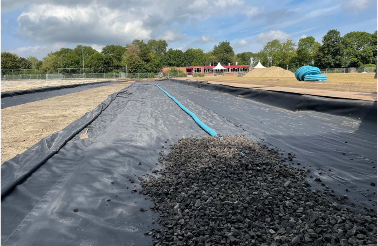
Opgehoogde primaire infrastuur (schuimglas)
