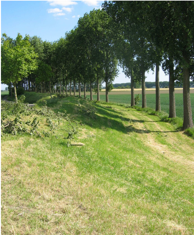
Figuur 5.13; Achterliggende dijk van Prosperpolder
