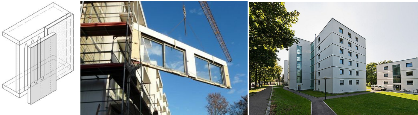
Figure 5.3: TES-envelope concept (left), TES energy facade on-site (middle), TES-energy facade applied on projectGrüntenstraße in Augsburg 2016 (sdg21) (Rigth)( Technische Universität München Fakultät für Architektur, (Cronhjort et al., 2014)
