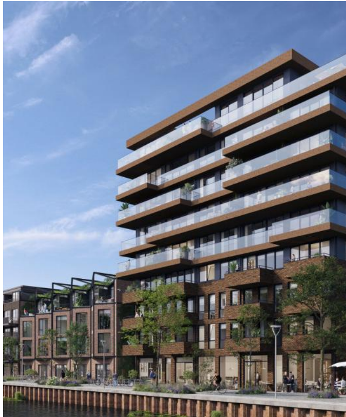
De Glasfabriek, Schiedam
