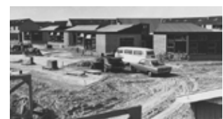
Basisschool De Cortendijk in aanbouw. (Foto: Thom van Amsterdam, Brabants Nieuwsblad)
