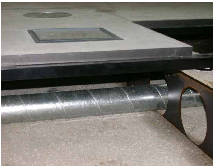
FIGUUR 2.17 Leidingvloer in brandweergebouw 'Rode Haan' in Delft (Bron: Amateurfoto, rechtenvrij)
