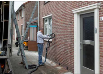
aanbrengen gevelisolatie (Bron: Capar de Haan)
