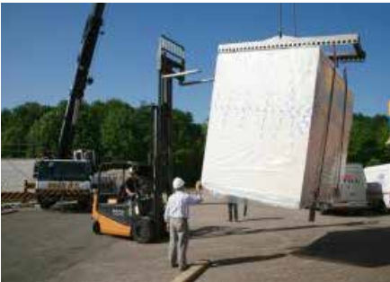
Aanvoer Prefab badkamer/toilet (Bron: Faay)
