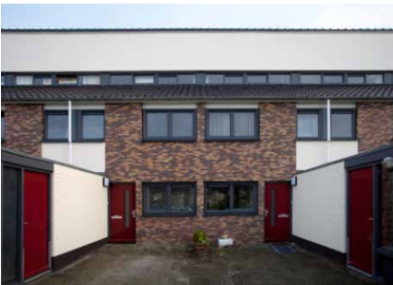
Renovatie Maarssenbroek (Bron: BAM)
