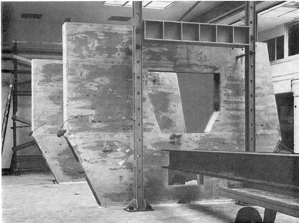
Fig. 18. De bij het model toegepaste pijlerconstructie.
