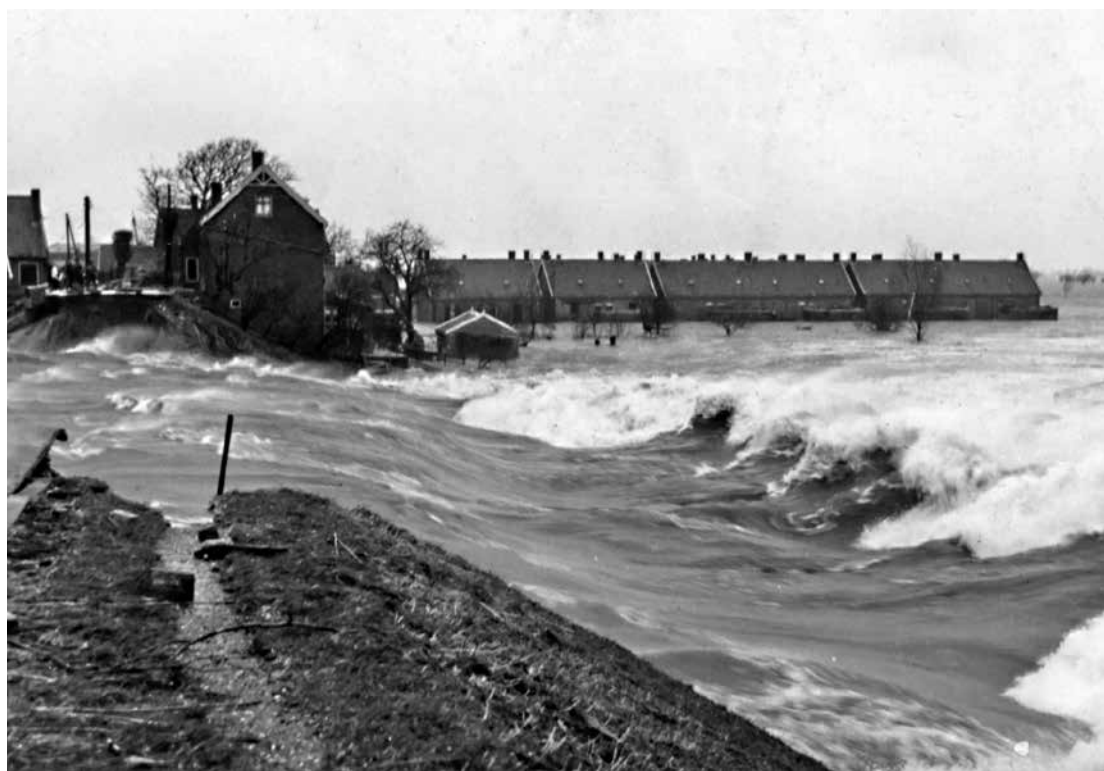
Afb. 3 Doorbraak Noorddijk in Papendrecht op 1 februari 1953. Beeldcollectie Graafstroom, inv.nr. 1112_1674, Regionaal Archief Dordrecht.
