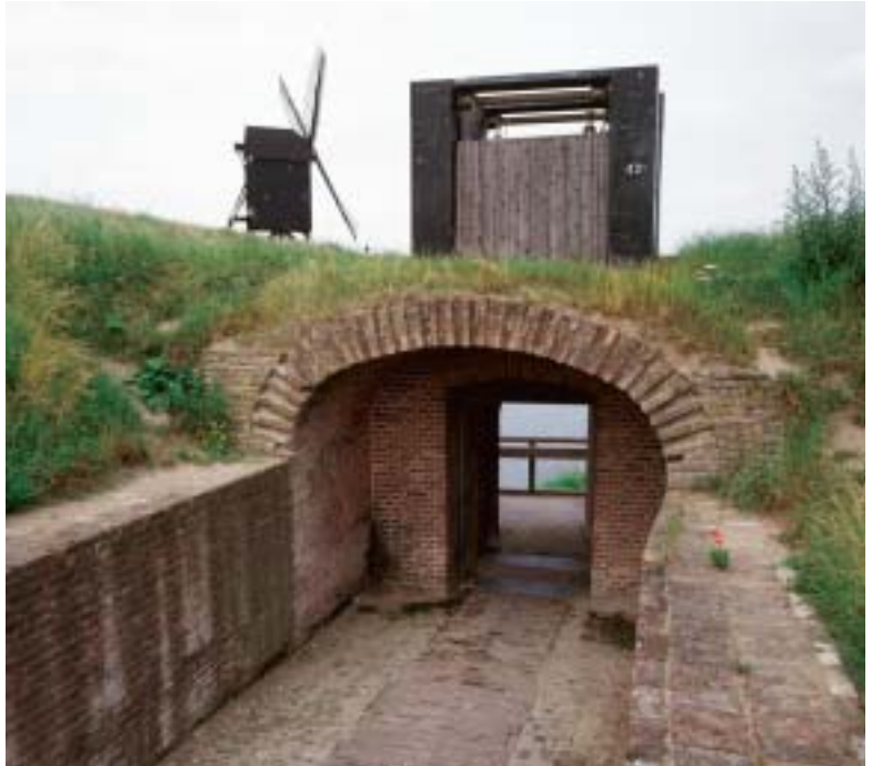
Foto 3.1 Bijzondere constructie: Coupure in de vesting- wal van Heusden, nabij de Waterpoort (foto MD)
