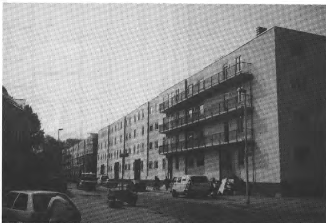
Hoogniveaurenovatie (Welschen 7, Overschie (Rotterdam))
