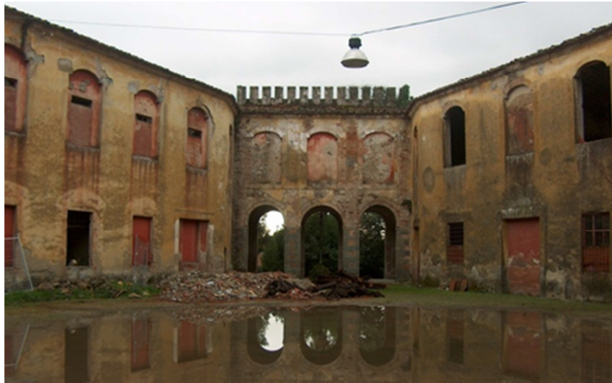
Fig. 4. Villa Mansi, Palazzina dell'Orologio.
