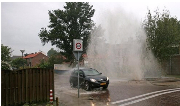
Figuur 1 - Voorbeeld van een leidingbreuk.
