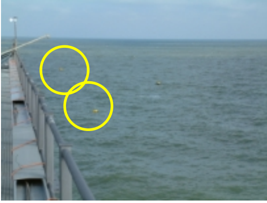
Figuur 3: Golfmeetboeien voor de stortsteengolfbreker van Zeebrugge.
