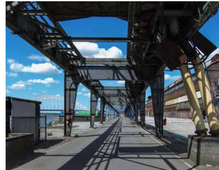
Figure 14: Nedstaal "Kraanbaan" (crane tracks) in 2018 (De Jong, 2018).
