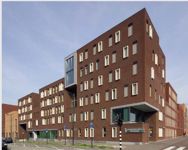
Figuur 48; Gezondheidscentrum Haveneiland te IJburg, Amsterdam
