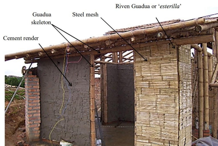
Figure 18. Bahareque Ecementado (NSR-10)
