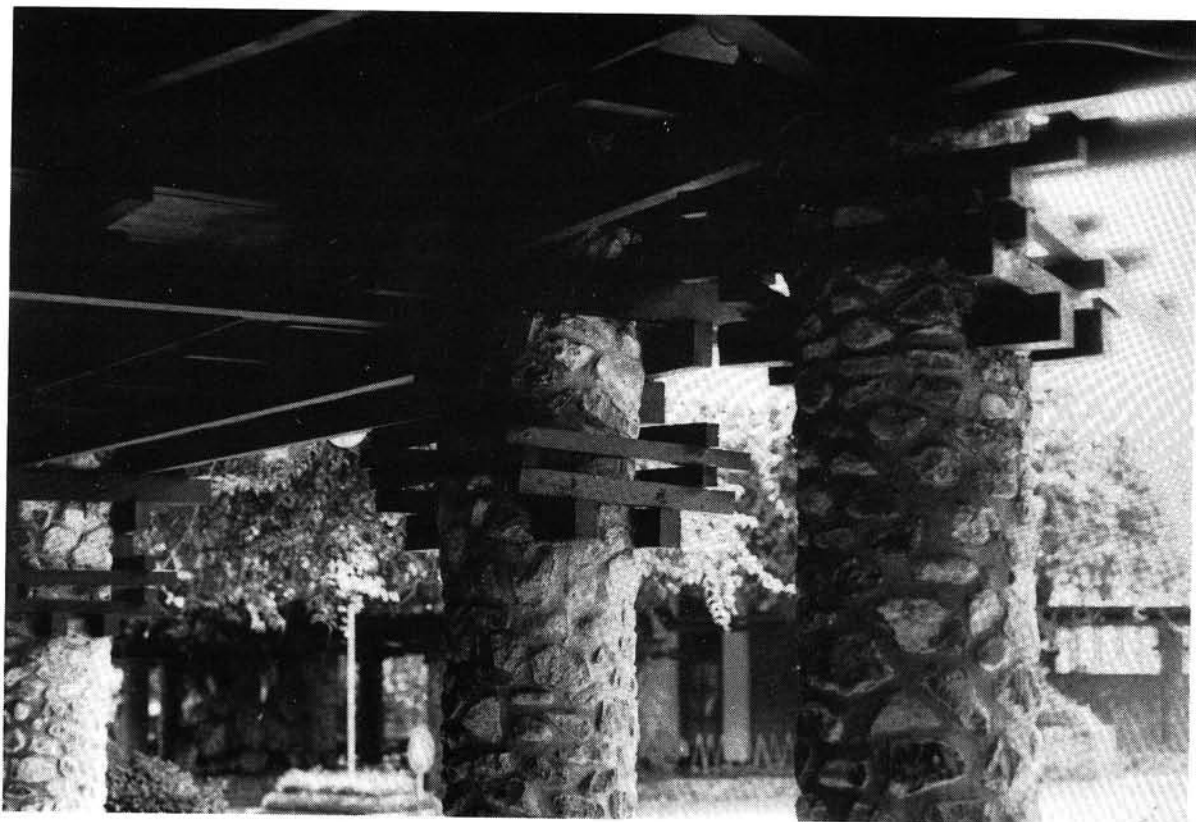
Afb. 6. Aansluiting van de houtconstructie met de gangkolommen.
