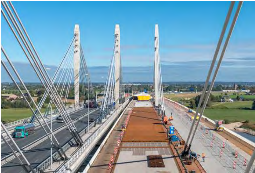
Vorbereiding HSB overlaging van de Tacitus brug te Ewijk
