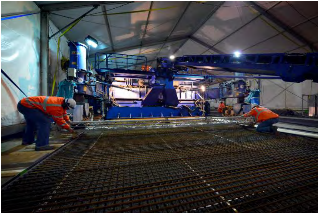
Aanbrengen HSB overlaging op van Galecopperbrug en Kreekkrakbrug
