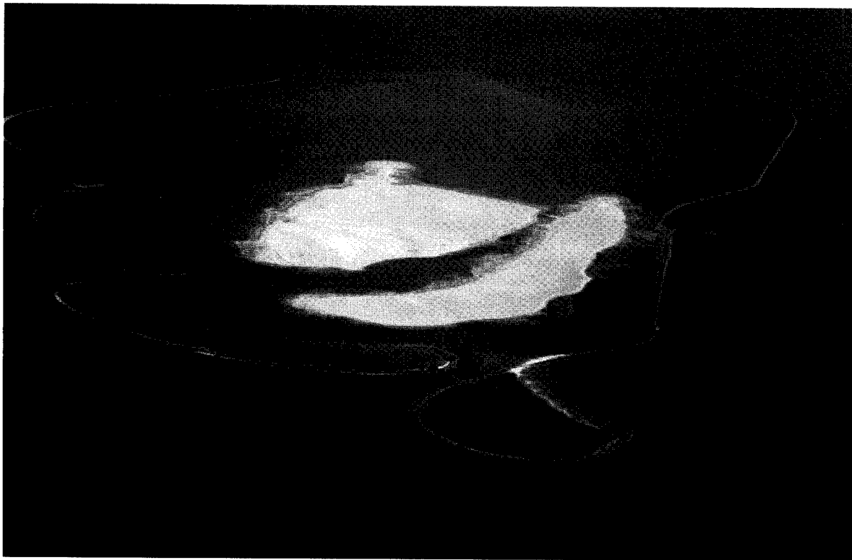
Haringvliet, Slijkplaat na het opsputten in 1998 (Aerocamera Hofmeester)
