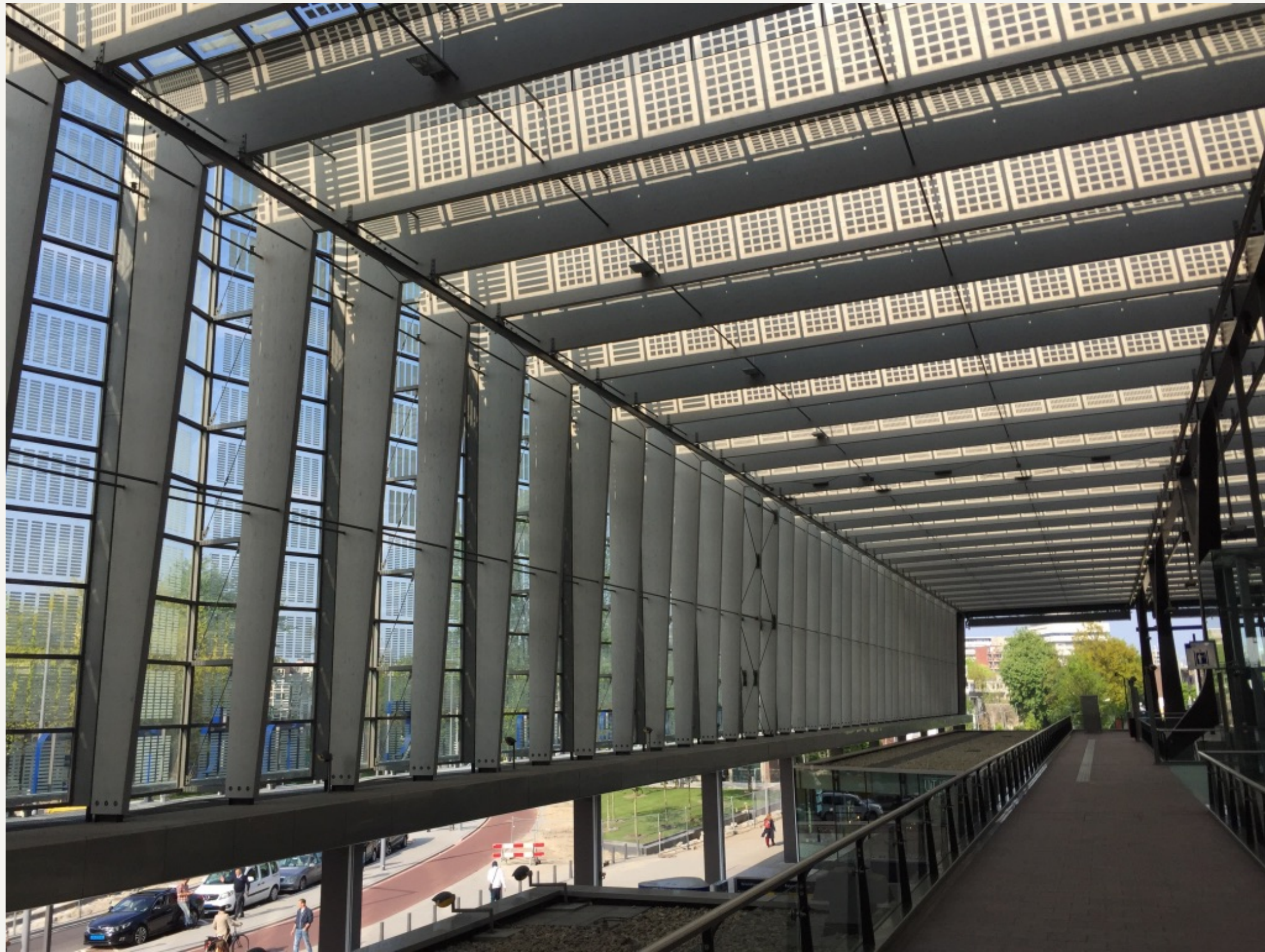
stationshal Rotterdam Centraal
