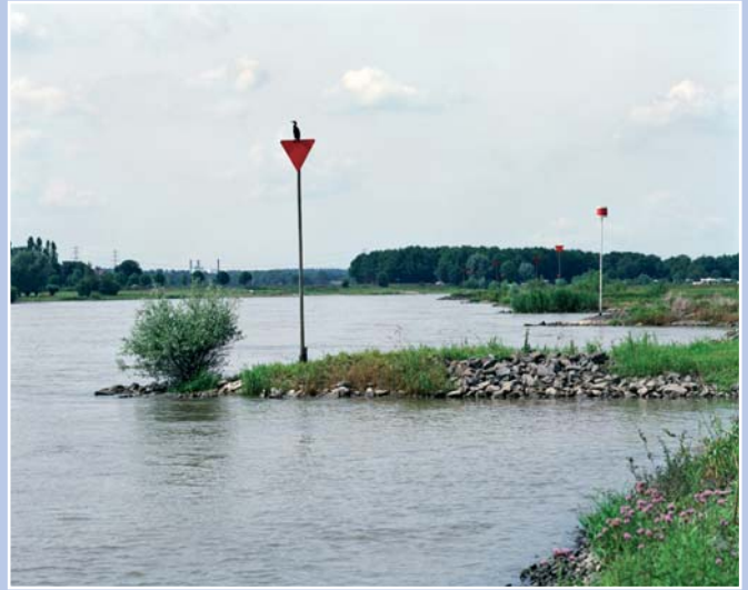
Figuur 9.9 Krib met kribpaal
