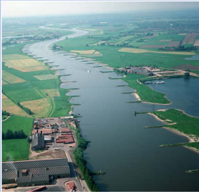
Figuur 9.8 Ongelijke kriblengten in een rivier
