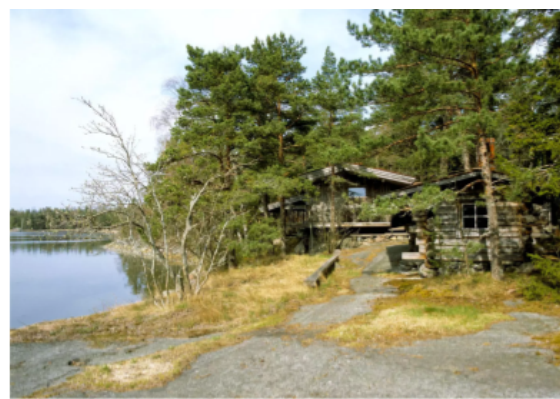
Figure 24: Exterior of Skata photographed by Jari Jetsonen in 2008. Katja Martelius. "Karujen rakennusten arkkitehdit toteuttivat unelmansa idyllisissä kesämökeissä." Helsingin Sanomat, 2016.
