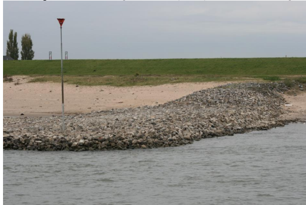
Afbeelding 4.8. Verlaagde krib en principe van aanzanding (Deltares, 2011)
