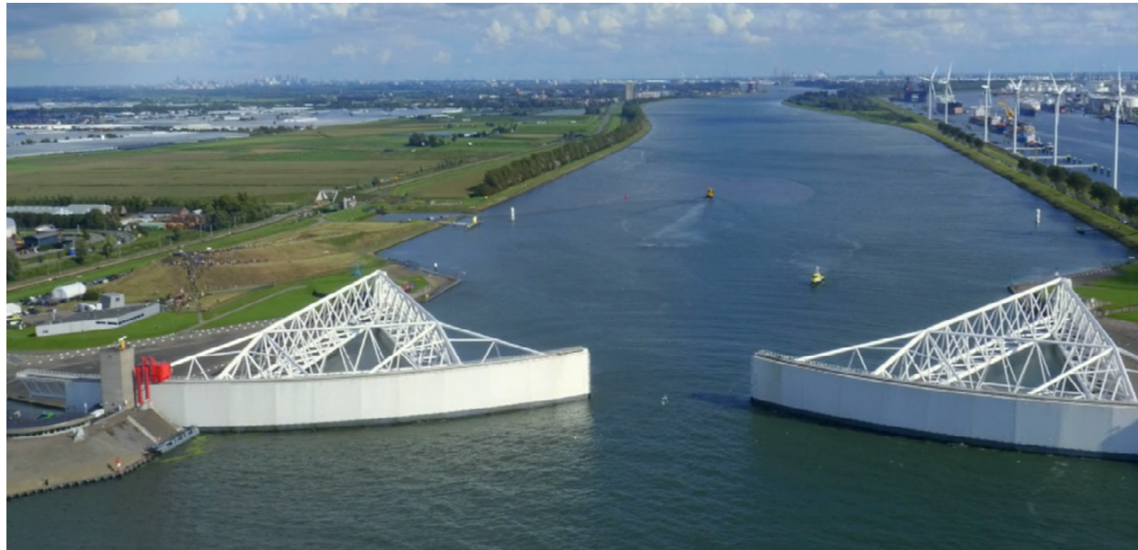
24. Hydraulic engineering references, Maeslantkering and Stormvloedkering Ramspol (Rijkswaterstaat, 2014)
