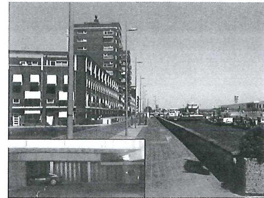
Referentieproject in Zwijndrecht: een ondergrondse parkeergarage maakt de kademuur van de Maasboulevard multifunctioneel. (Foto: Van Mechelen)
