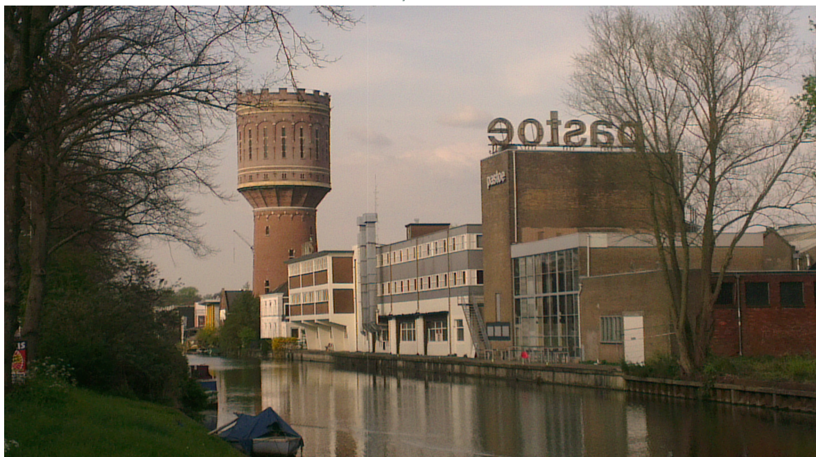
FIGUUR 13 AANZICHT WATERTOREN MET OMLIGGENDE BEBOUWING (EIGEN ILL., 2014)
