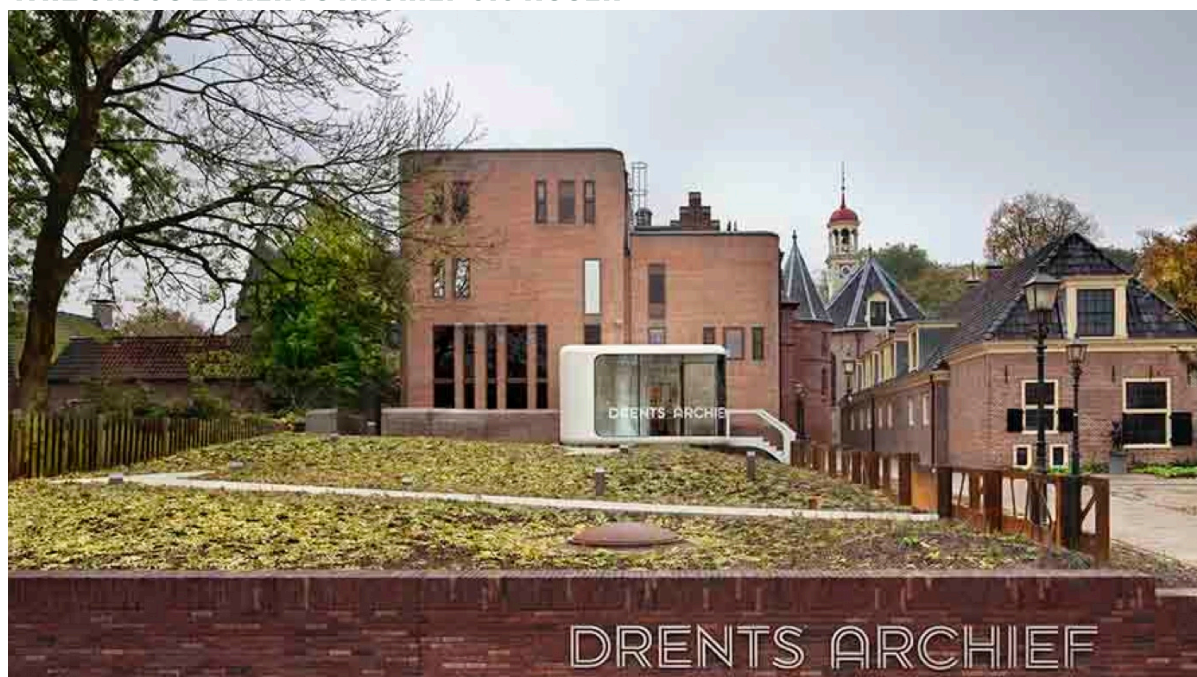
FIGUUR 12 EXTERIEUR WAAR DE GEBOUWONDERDELEN UIT VERSCHILLENDE PERIODES ZICHTBAAR ZIJN ((ZECC ARCHITECTEN, 2012)
