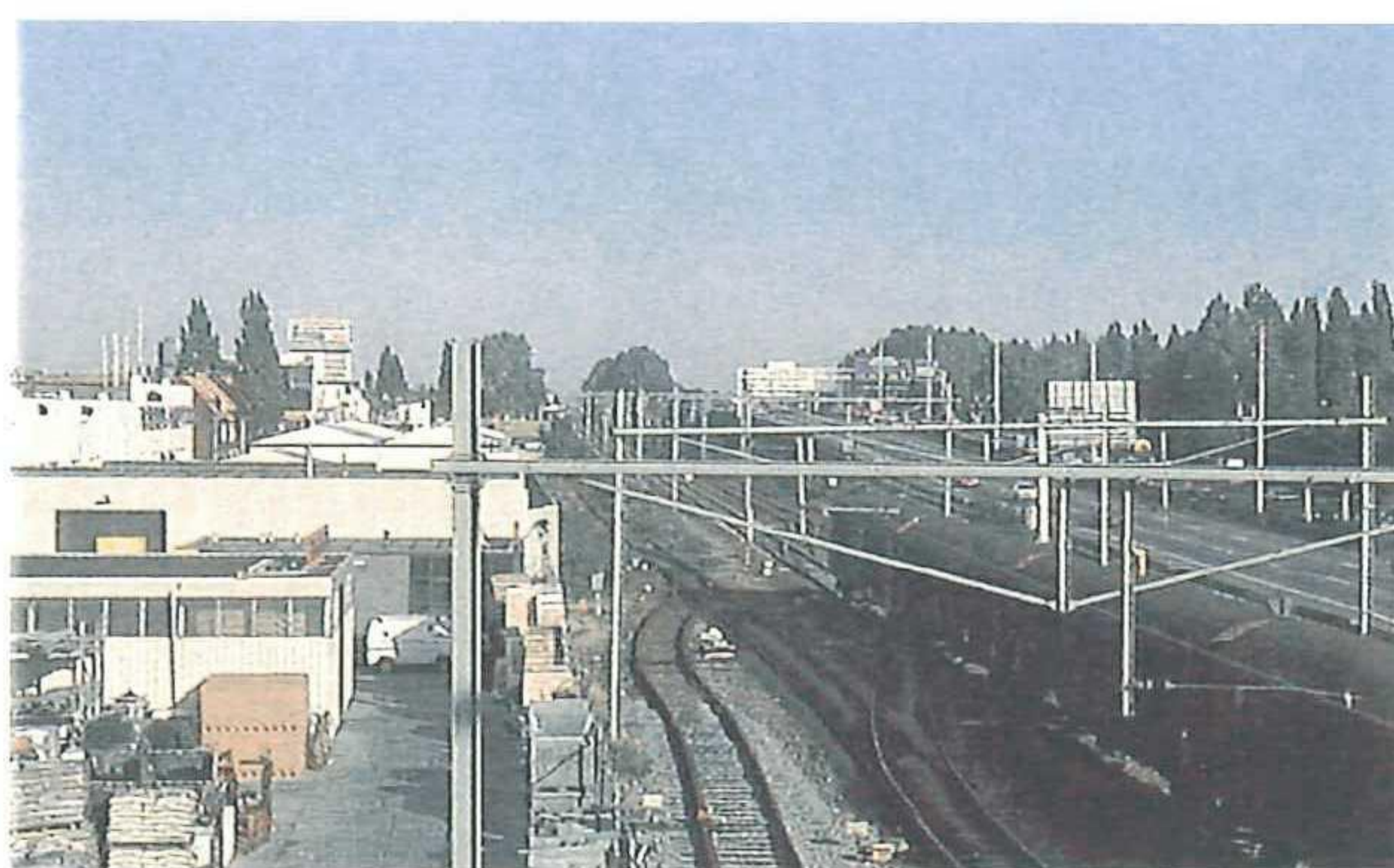
figuur 3.9: spoorlijn Rotterdam-Utrecht
