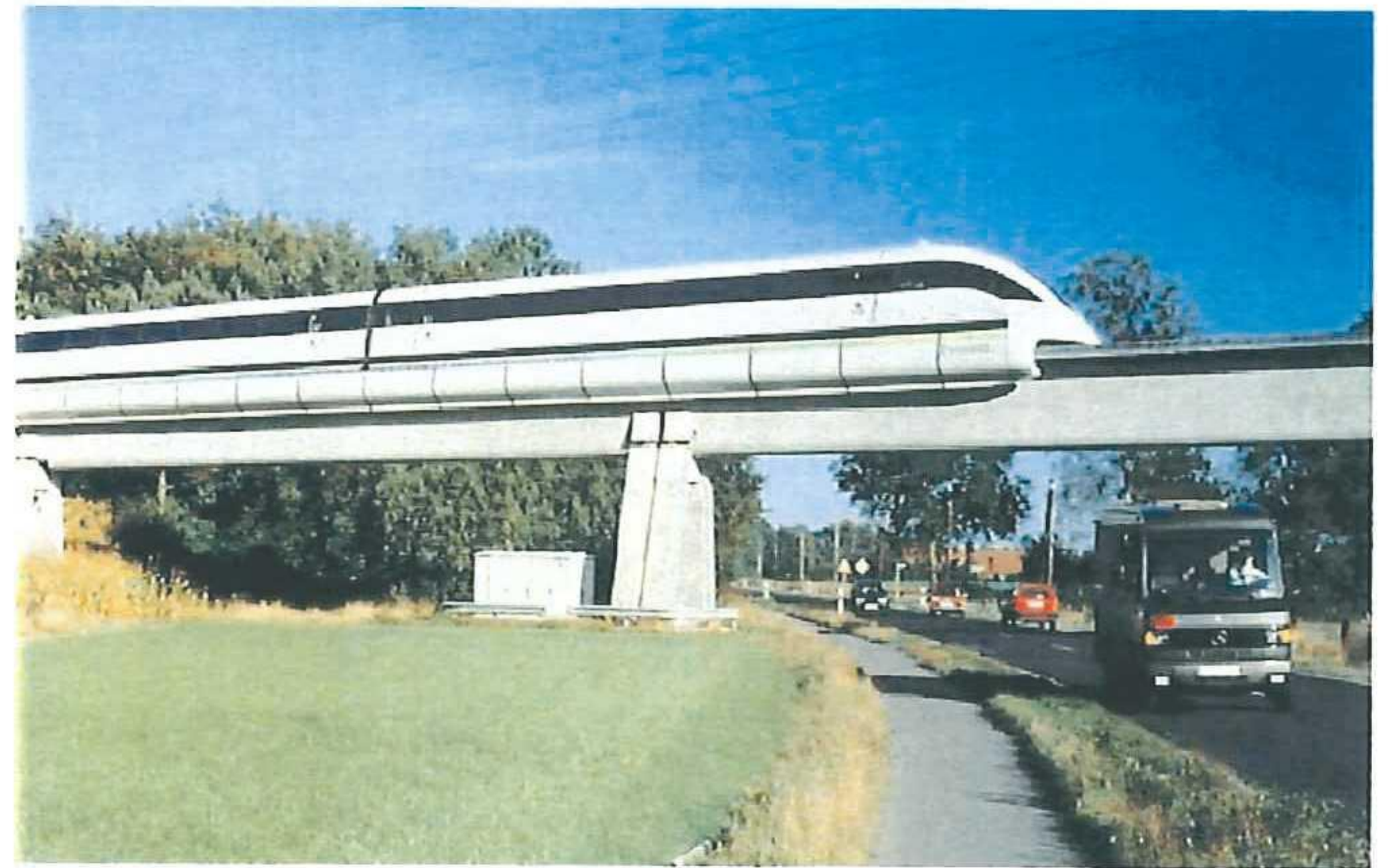
figuur 3.38: Transrapid op viaduct, relatief lichte constructies bron: www.transrapid.nl
