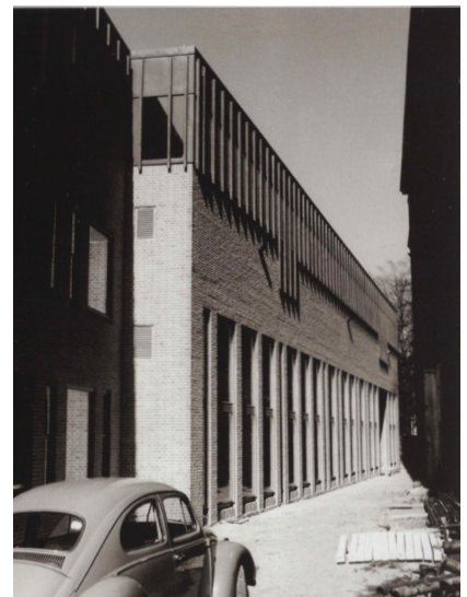
Figuur 39: De voorgevel van het postkantoor naast het Rijksopvoedingsgesticht.
