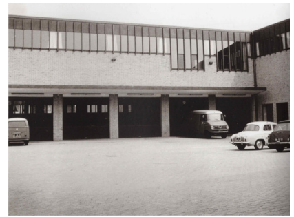
Figuur 32: Het binnenplein met de betonnen luifel en grote garage deuren voor het laden en lossen van de postwagens.
