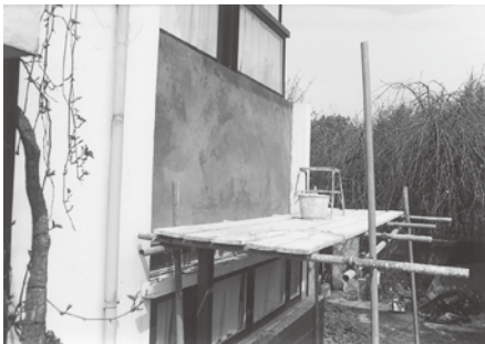
图 15: 除去带有裂缝的石灰后, 墙面被涂上一层单一均匀的新涂料
