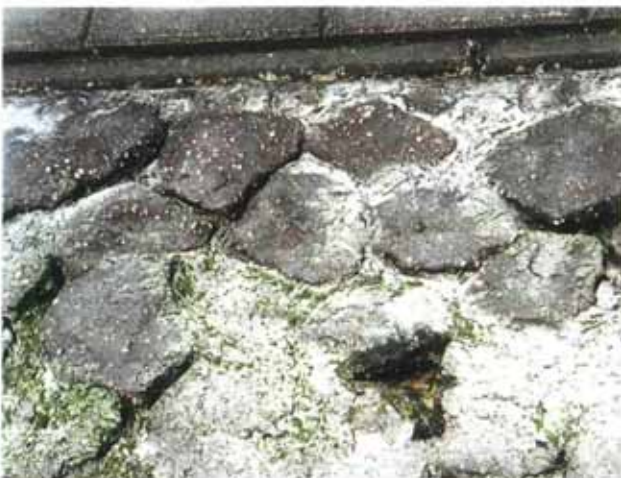
Foto 2.12 Ingegoten steenzetting
