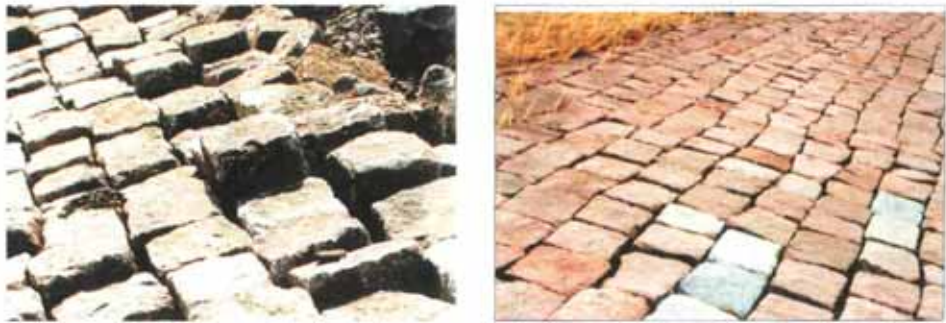
Foto 2.9 Toplaag natuursteen vlakke onderkant (links) en toplaag natuursteen vlakke bovenkant
