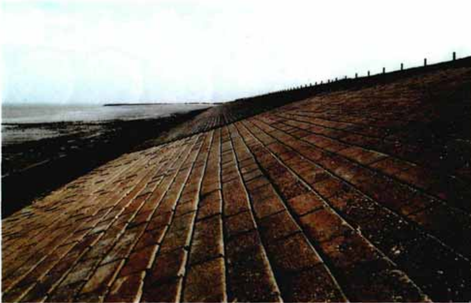
Foto 2.8 Gekantelde betonblokken
