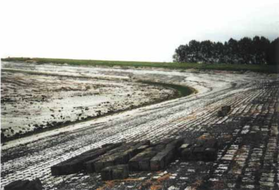
Foto 8.1 De Hellegatpolderdijk tijdens de reconstructie
