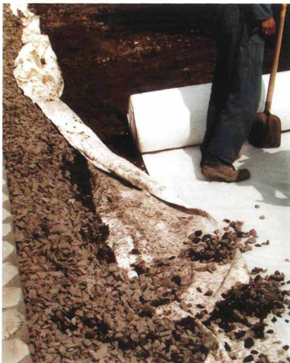
Foto 2.14 Geokunststof op de rol tijdens aanbrengen
