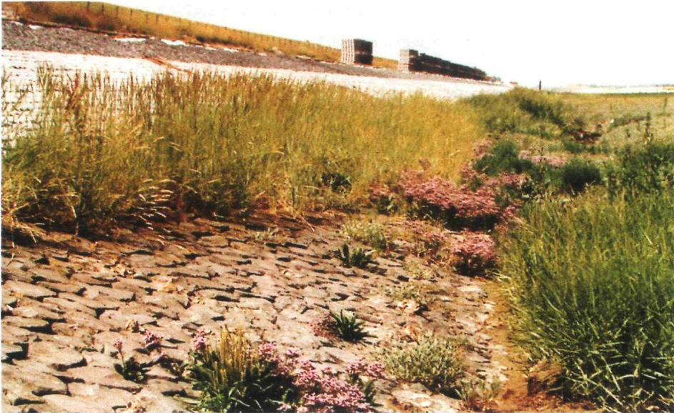
Foto 1.1 Begroeiing op bekleding van gebakken steen
