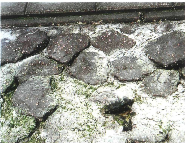
Foto 2.12 Ingegote steenzetting
