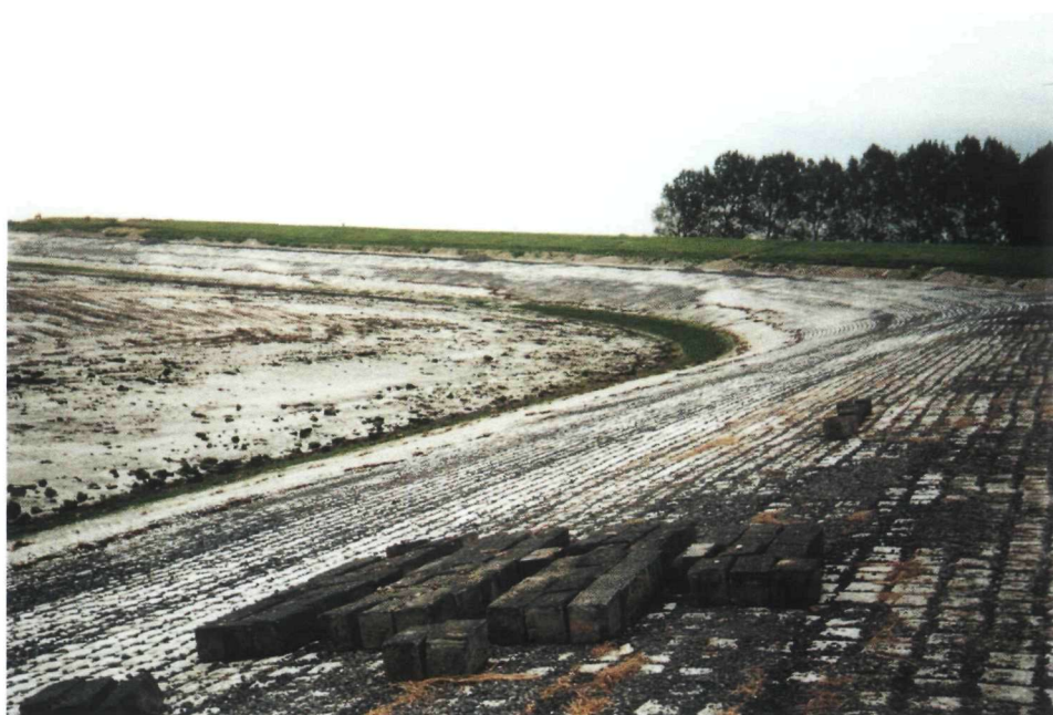
Foto 8.1 De Hellegatpolderdijk tijdens de reconstructie
