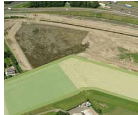
Leidingenstrook als herkenbaar element in het landschap
