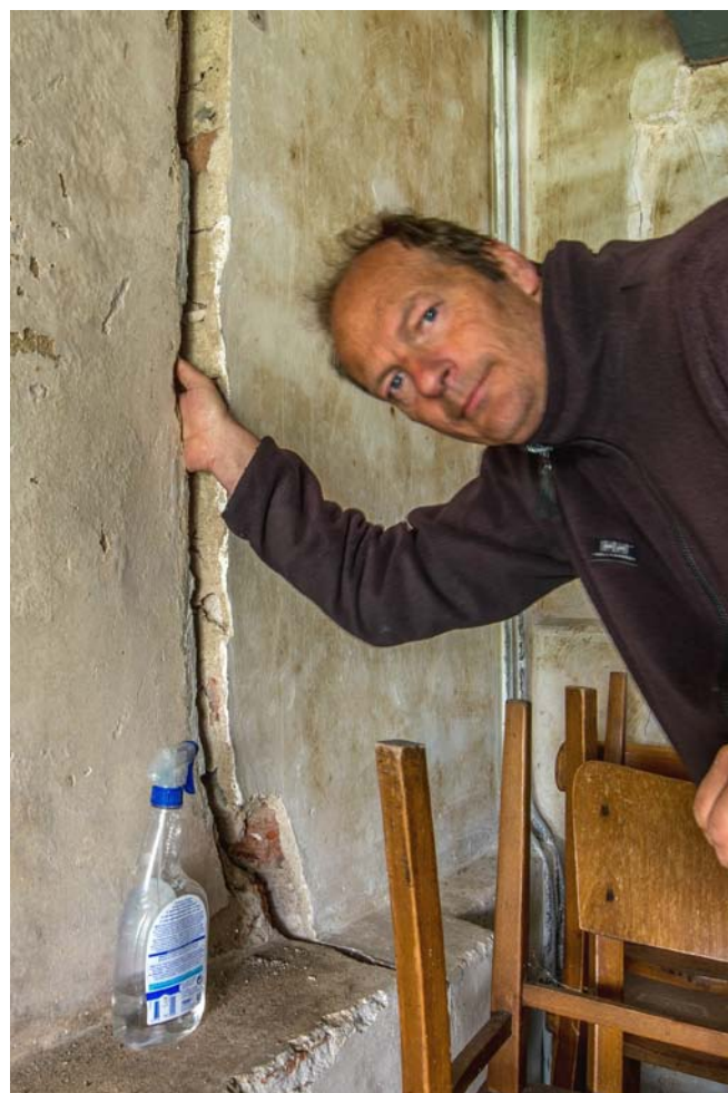
Fig. 11 Jos Stöver van de Rijksdienst voor het Cultureel Erfgoed steekt zijn hand in een brede scheur in het muurwerk op de plek waar de oostgevel van de toren aansluit op de westmuur van de kerk. Foto (met zelfontspanner) J. Stöver, mei 2015.
