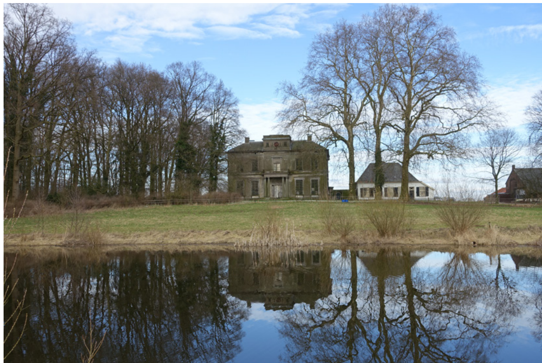
FIG. 8 Reuversweerd exterior in 2017 (source: Hielkje Zijlstra)
