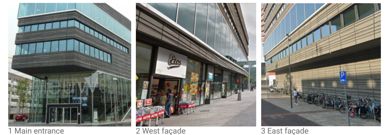
Figure 38: Façades Nieuwe Bibliotheek
