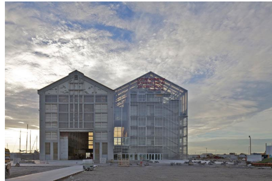
FRAC, Nord Pas-de-Calais. Dunkerque (FR), Lacaton & Vassal Architectes, 2013
