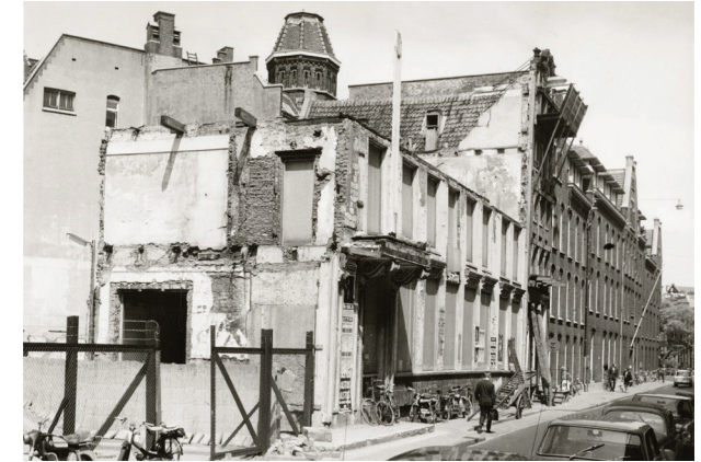
Fig 5.3 Demolishing of Hotel de Pays-Bas Stadsarchief Amsterdam Beeldbank 010122015519
