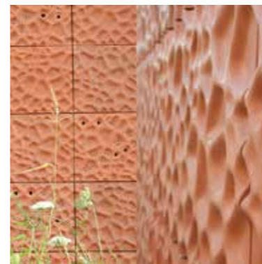
Nabasco Facades Gevelpanelen van rietmaaisel
